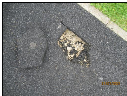
(Damaged wet pour)
